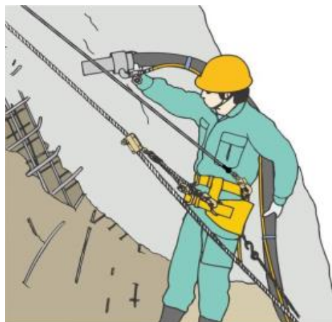
のり面保護作業
