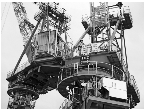
写真1 クレーン上のオペレーター
